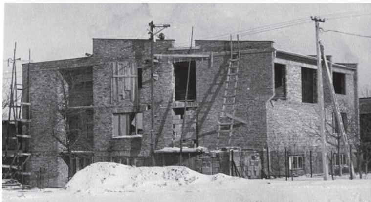
Budynek Zborowy w trakcie przebudowy 1977 r.
