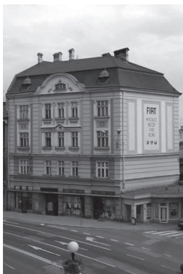
tak wygląda obecnie budynek gdzie mieszkał J.Prower przez 21 lat aż do śmierci-3 piętro wszystkie
